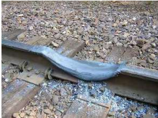
Un rail très gravement endommagé à cause d'une roue qui a tourné sur elle-même sans avancer
